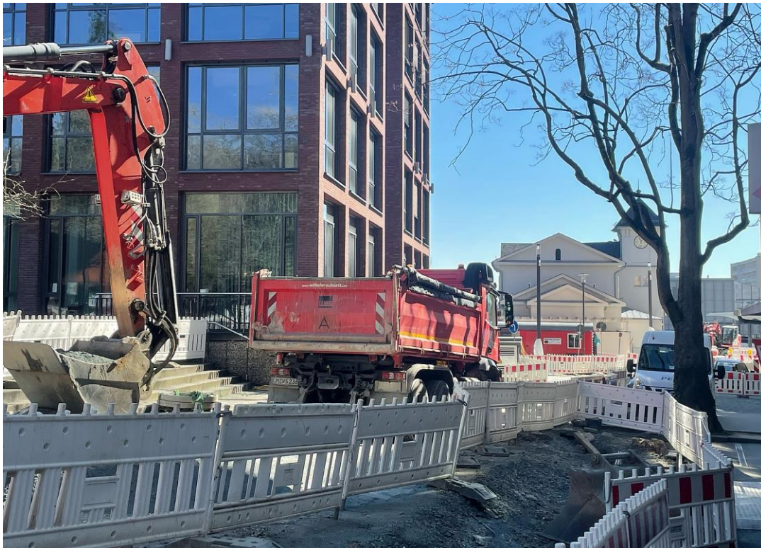
Fußgänger kommen immer noch an der Baustelle in der Straße Am Bahnhof. Foto: Stadt Bad Soden am Taunus. Dieses Bild steht HIER zum Download bereit.
