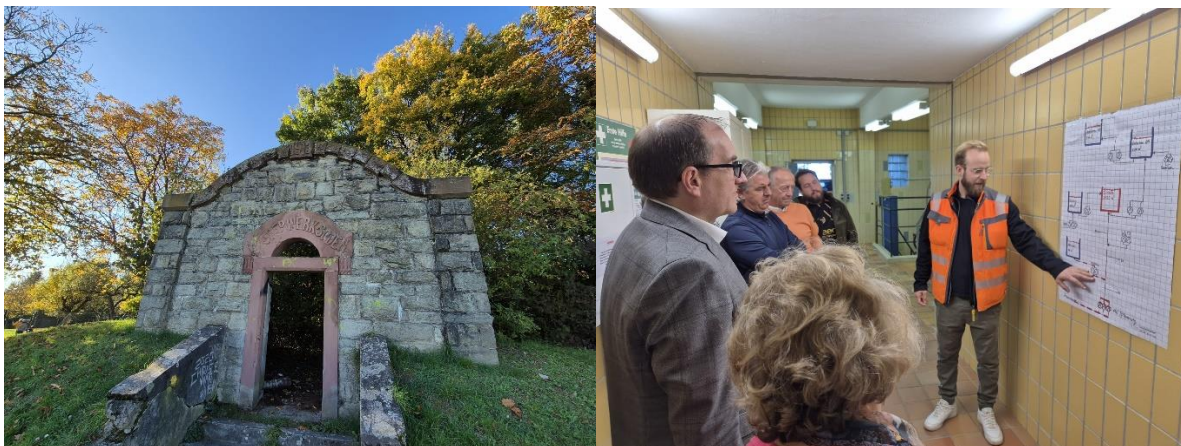
Das alte Eingangsportal des Hochbehälters „Am Gickel“ (links). Auf einer vorbereiteten Skizze erläuterte Wassemeister Philipp Arnoldt die Wasserversorgung der Stadt (Foto rechts). Quelle: Stadt Bad Soden am Taunus Dieses Bild steht HIER zum Download bereit.
