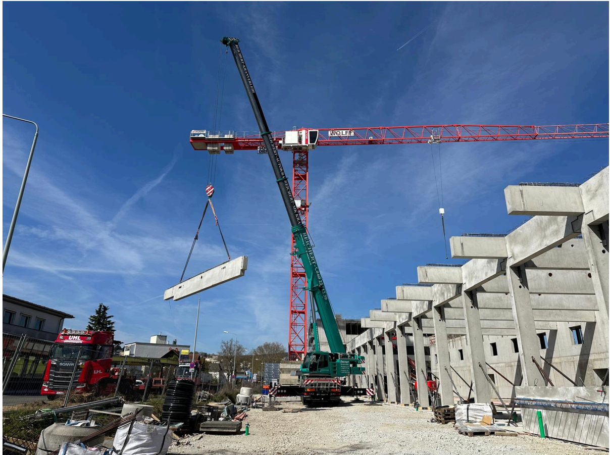
Die fast 14 Tonnen schweren Fertigteilbinder wurden in dieser Woche angeliefert und eingepasst. Foto: Stadt Bad Soden am Taunus
