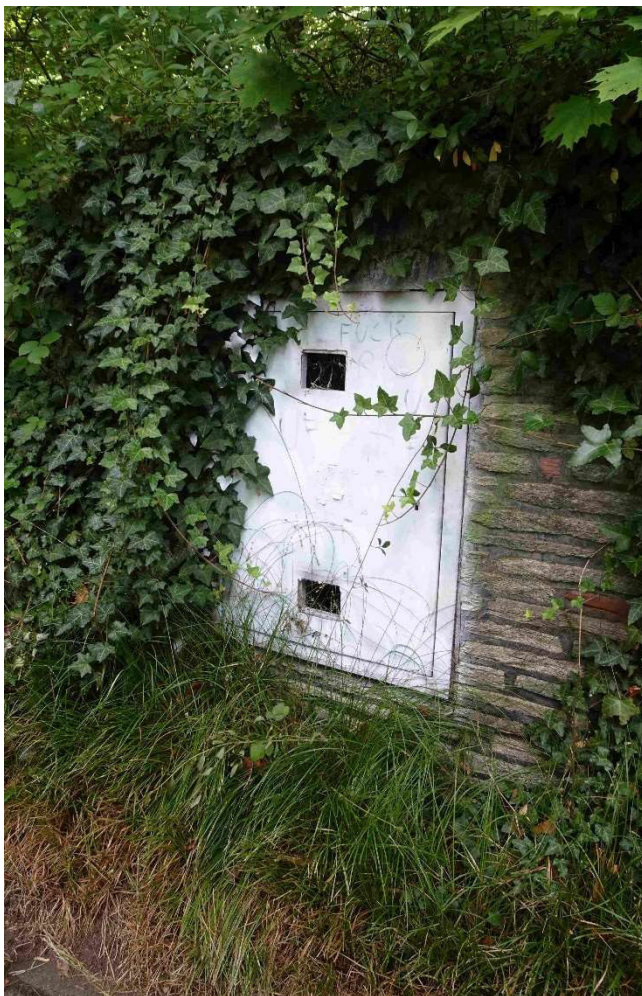
Abb. 15 u. 16: Einlassbauwerk zu einer stillgelegten technischen Anlage an der Parkstraße im Westen des Plangebiets, Stahltür mit Lüftungsöffnungen / Obere Lüftungsöffnung mit Spinnweben
