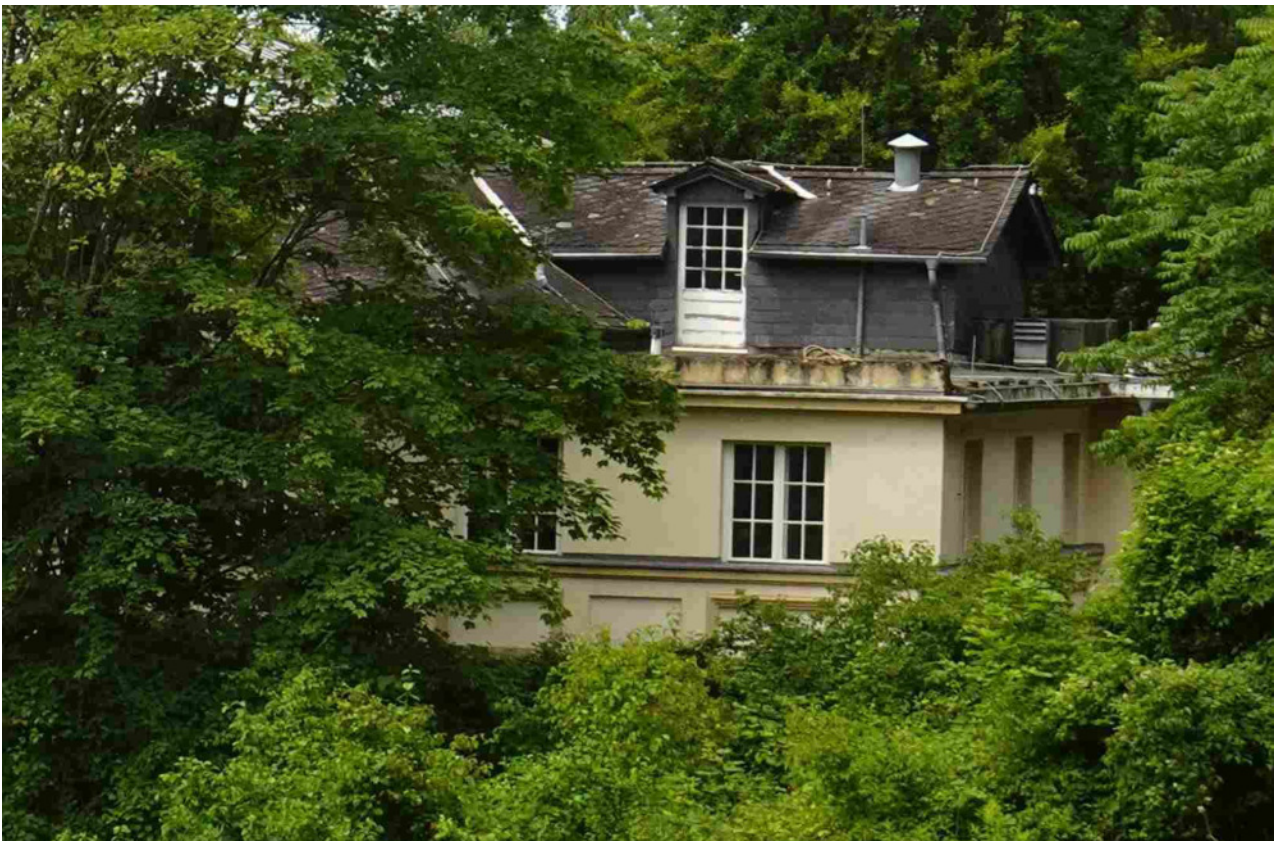
Abb. 6: Dachaufbauten des Medico-Palais, Ansicht von Osten
