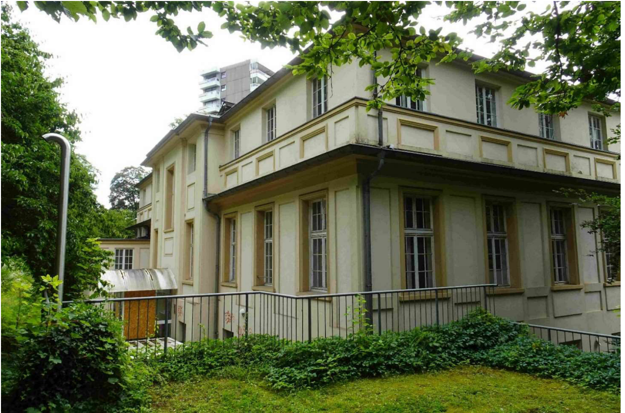
Abb. 5: Medico-Palais, rückwärtige Fassade, Ansicht von Nordwesten
